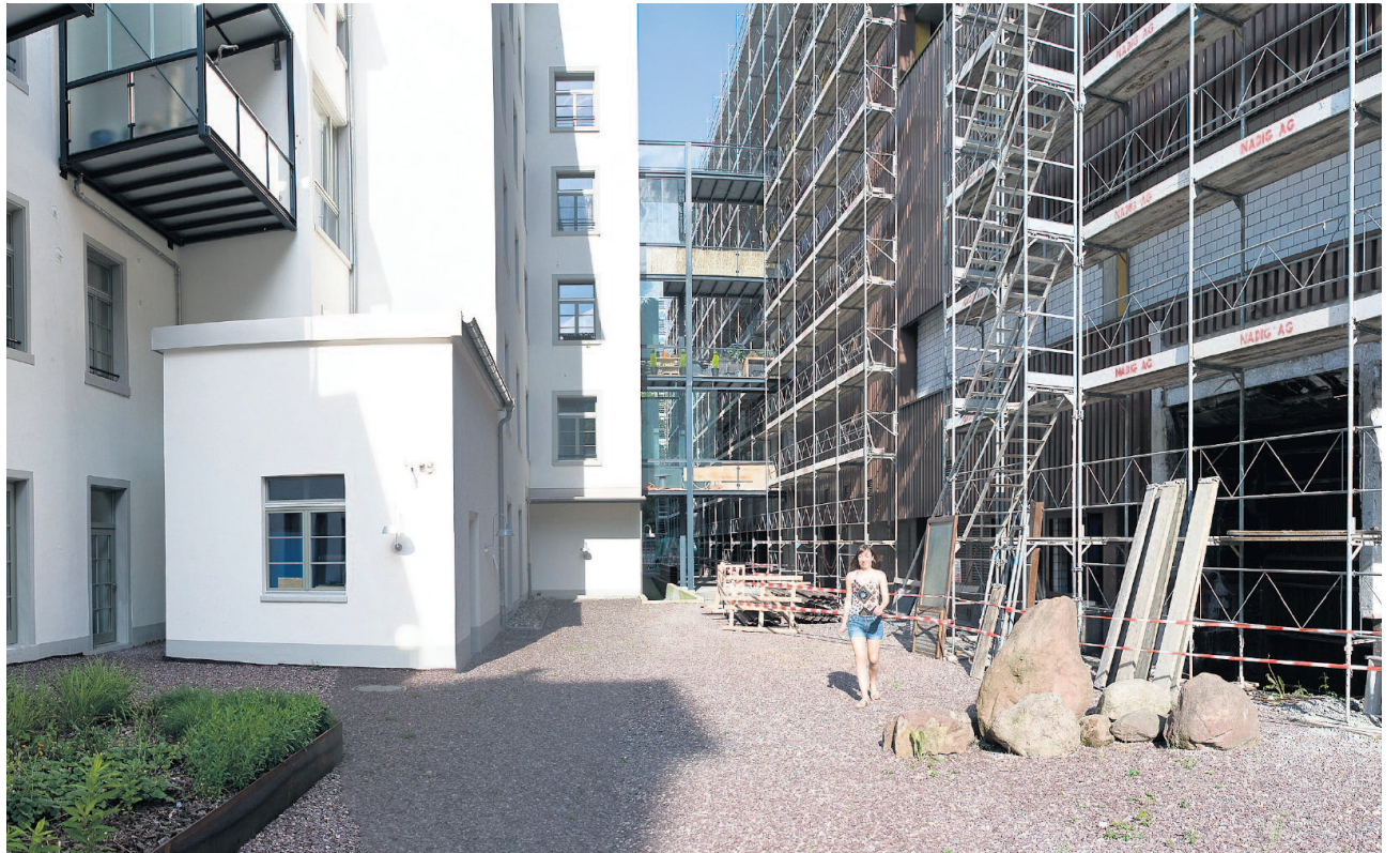
Wird mit Passerellen mit dem Hauptgebäude verbunden: Der «Neubau», der in der dritten Bauetappe errichtet wird.
