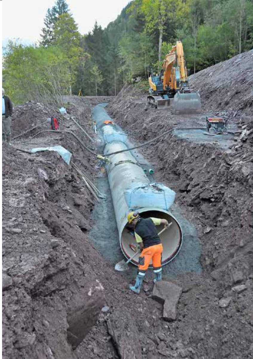
Trotz Baggern fehlt es nicht an Handarbeit: Auf Hochtouren laufen dieser Tage die Erneuerungen der Leitungen der EW Schils AG.
